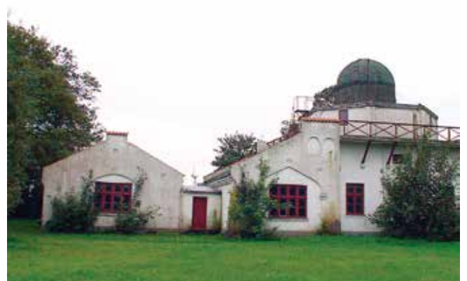
Oven over ses Bygningerne fra nordsiden. På toppen af hovedbygningen ses observatoriet. Det måtte vi desværre tage ned få år senere, fordi kuplen var rådnen. Kikkerten er lagt på depot, men det kunne være spændende at få den op igen.
